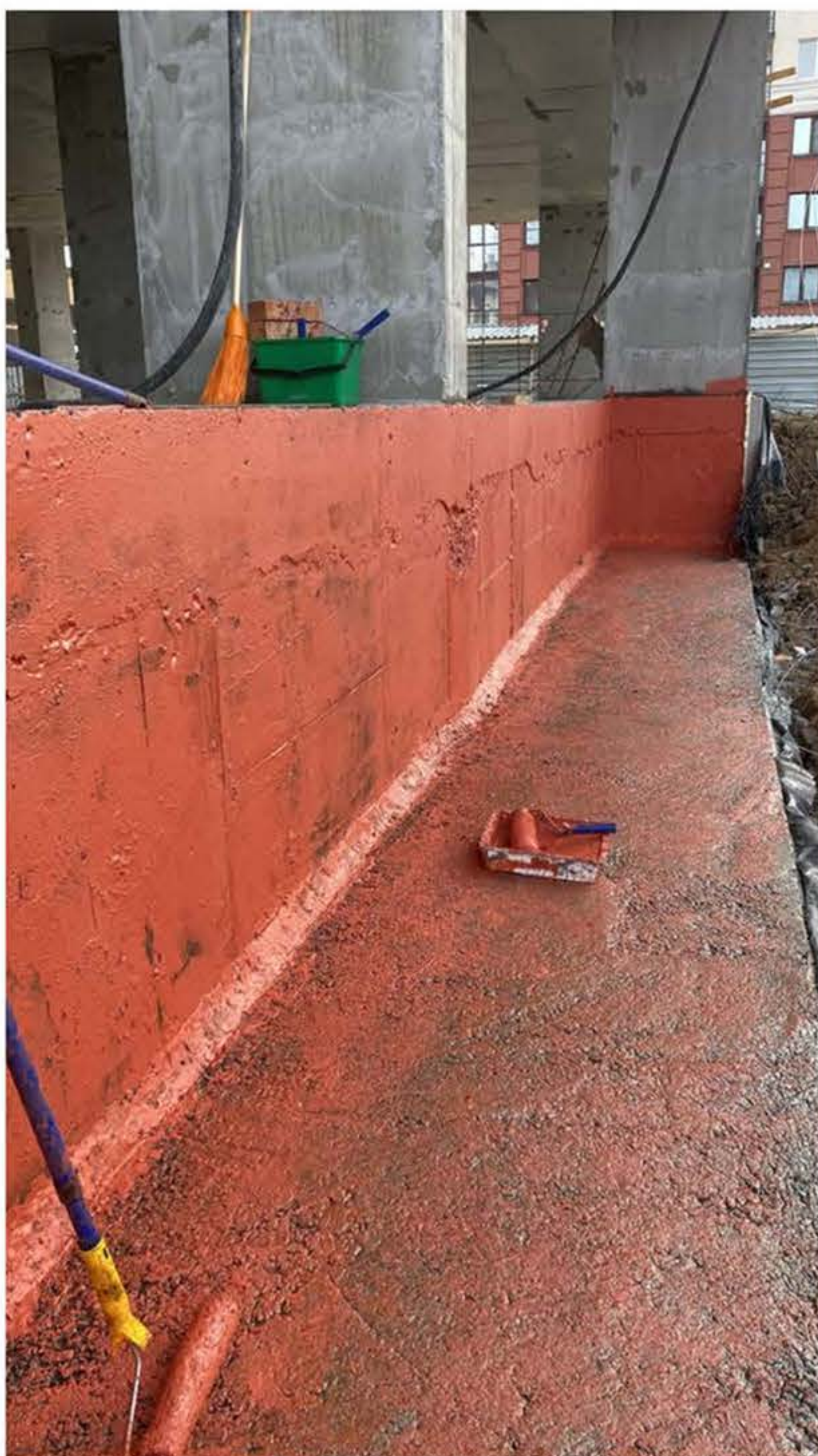
Полный комплекс гидроизоляции
