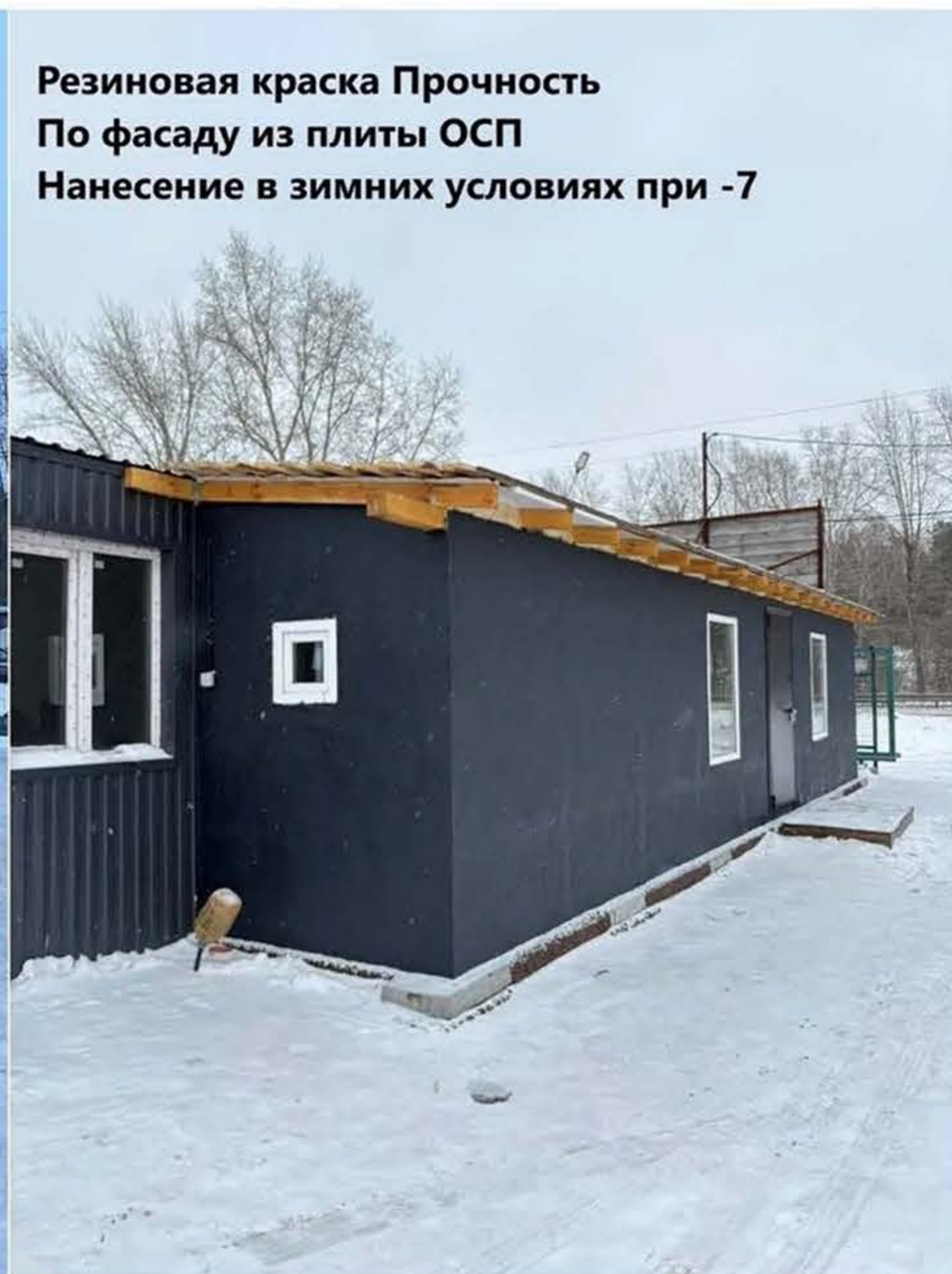
Защитное теплоизоляционное и гидроизоляционное покрытие швов ОСП Краска-герметик теплоизоляционная Гидротермаль
