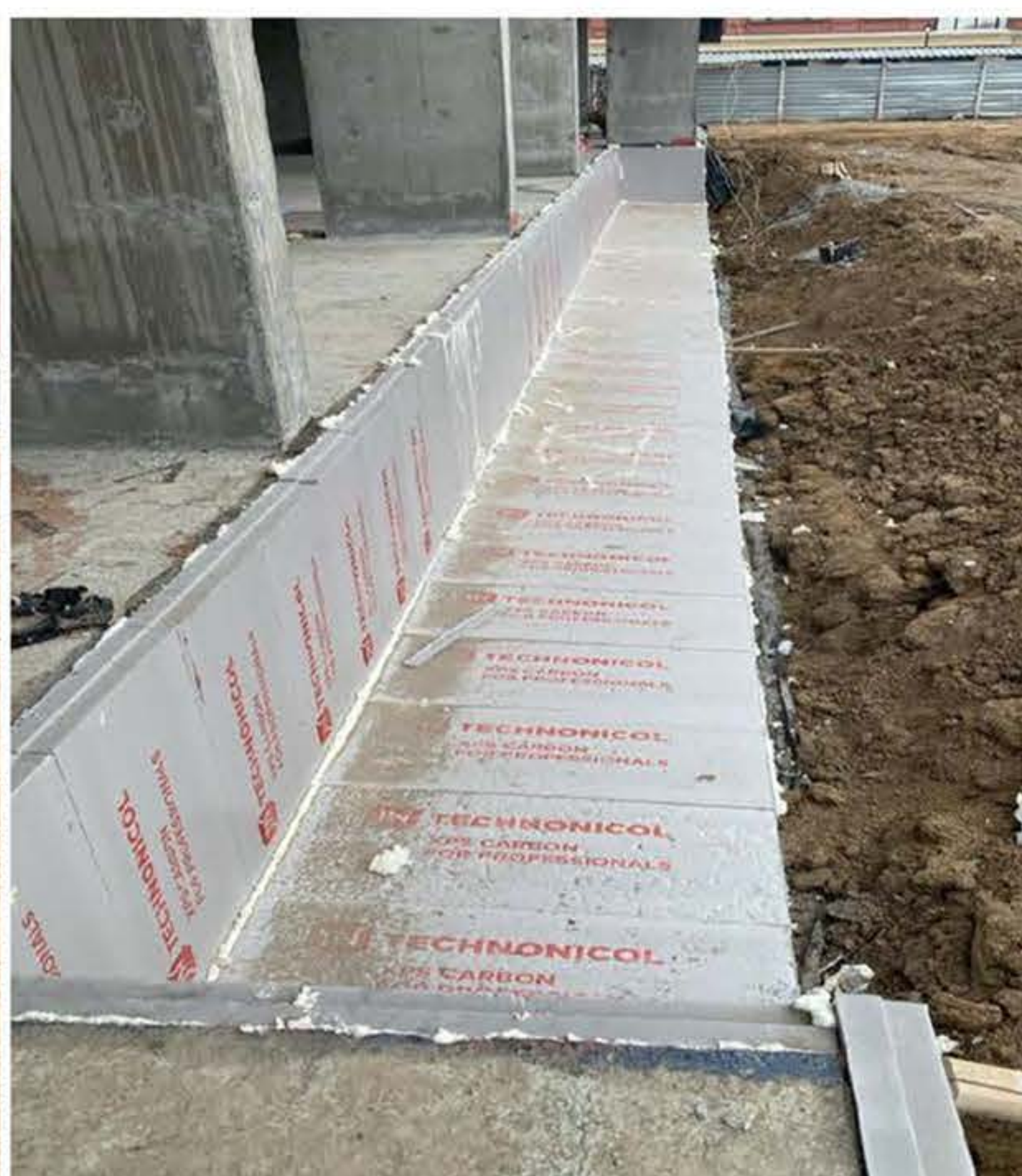
Утепление пеноплексом
